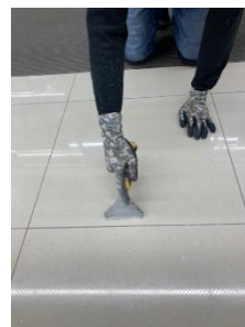
既存ドット撤去
