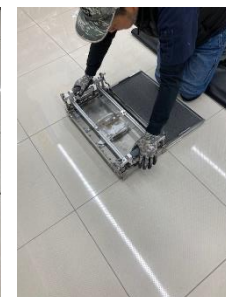
新規ドット施工
